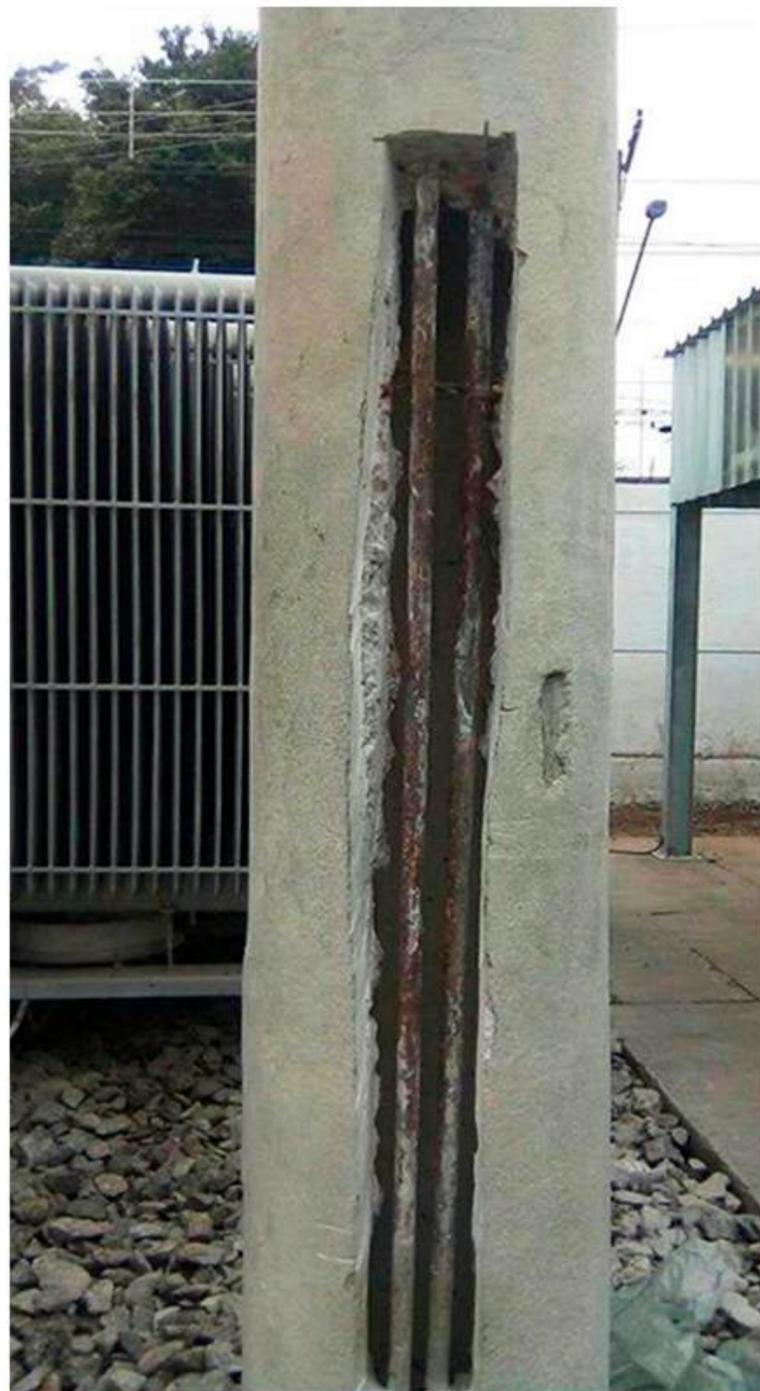
Corte do concreto para liberação e tratamento da armadura
